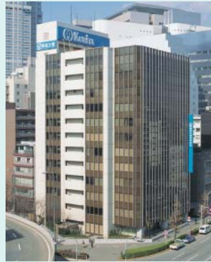
Head Office 本社
