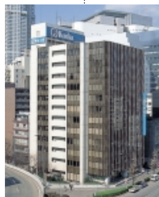
Head Office 本社
